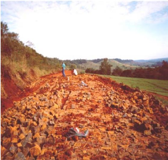
Figura 32: Aplicação de poliedro na construção de estradas
