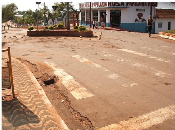
Figura 68: Condições deficitárias da Av. Brasil, meio fio, drenagem pluvial e faixas de pedestres
